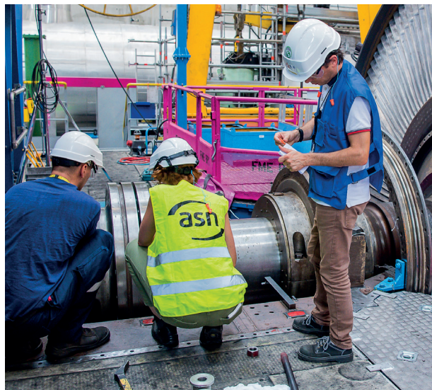
Inspection de l'ASN à la centrale nucléaire du Blayais – Turbine en maintenance
