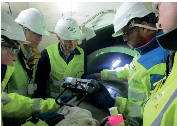
Inspection de l'ASN sur le chantier de l'EPR de Flamanville sur le thème des contrôles non destructifs de fin de fabrication des soudures des tuyauteries des circuits VVP et ARE – Avril 2018
