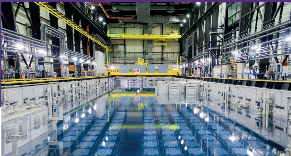
Piscine d'entreposage de combustibles de La Hague
