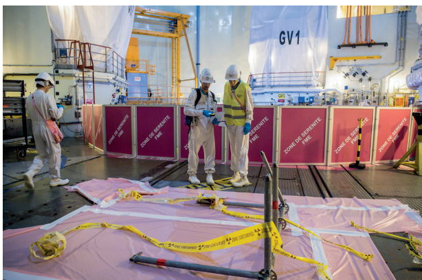
Inspection de l'ASN à la centrale nucléaire du Blayais – Moyens mis en place pour gérer le risque de corps étrangers dans les circuits
