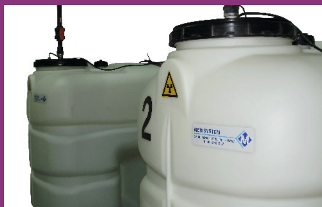
Cuves de décroissance
