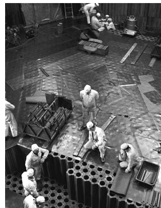
Empilements en construction
