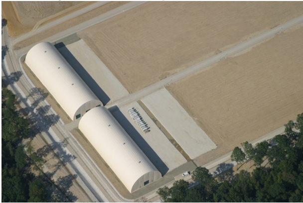
Vue aérienne d'un alvéole de stockage
