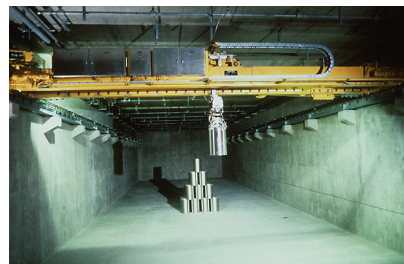
Entreposage des colis d'enrobés bitumineux
