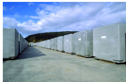
Conteneurs béton-fibres cubiques à Marcoule
